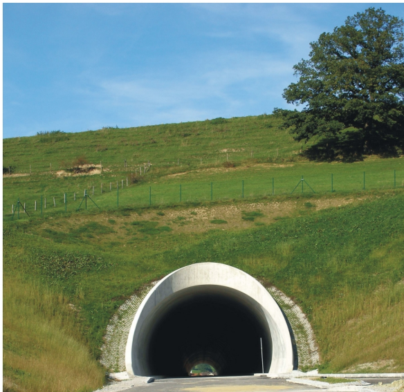
Bild 2: Einfahrtsportal Tunnel Umfahrung Peißenberg
