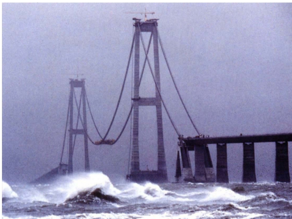
Bild 1: Bauwerke in chloridhaltiger Exposition, hier: Große-Belt-Brücke
