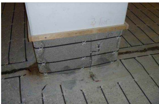
Bild 3: Stützeninstandsetzung mit KKS
